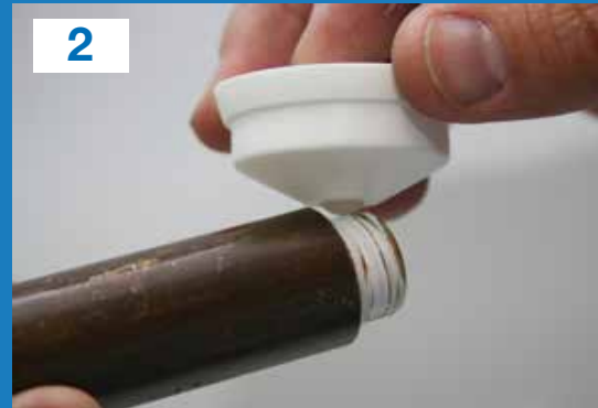
商品の底に付属されている潤滑剤をネジ部分全体に塗布します
